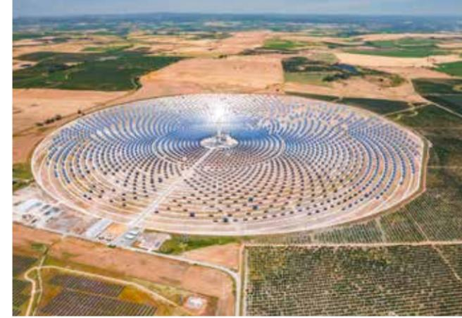
**SONNE SATT:** Die 2.650 Spiegel des spanischen Kraftwerks Gemasolar werden von Antrieben aus Bargteheide bewegt.
