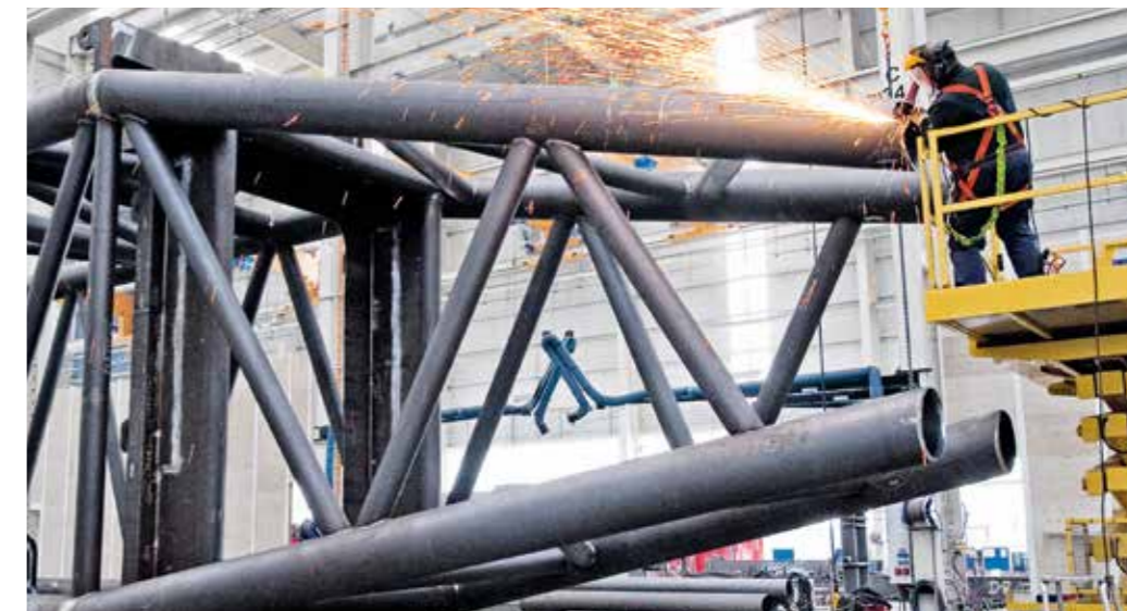
STAHLBAU: Ein Liebherr-Mitarbeiter bei Schweißarbeiten an einer Kran-konstruktion.
