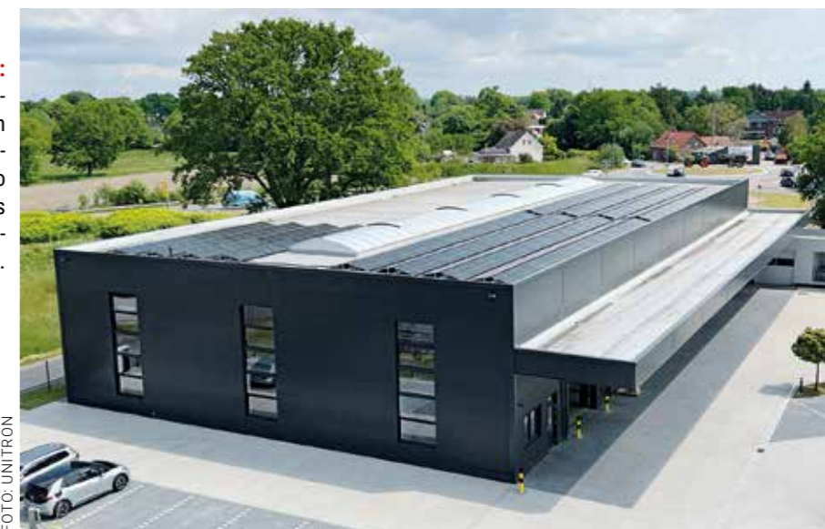
SAUBER: Die Photovoltaik-Anlage auf dem Dach des Logistikzentrums liefert so viel Strom, dass Unitron weitgehend autark ist.
