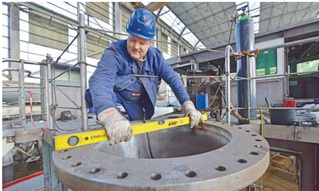
KONTROLLE: Schiffbauer Detlef Schlie überprüft das Fundament, auf das später der Knickteleskopkran der Firma Palfinger montiert wird.
