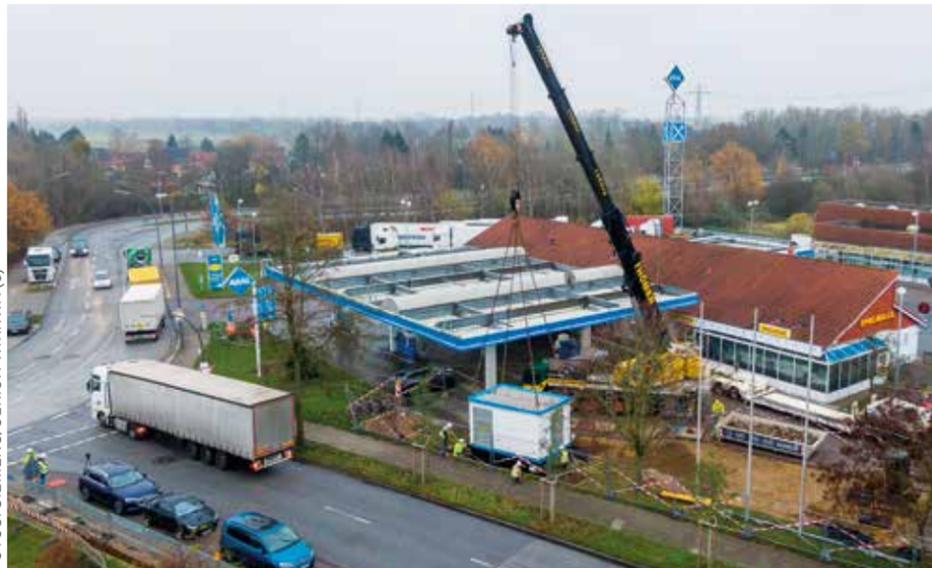
**INSTALLATION:** In Hamburg-Allermöhe angekommen, wurde die Ortsnetzstation per Kran an die Stelle gehoben, wo sie heute steht. Die beiden Ladesäulen folgten einige Tage später.
