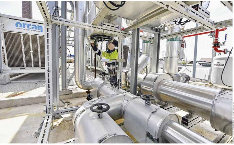
VOLLES ROHR: Instandhaltungsmeister Christoph Lübben öffnet ein Dampfventil der neuen Anlage zur Nutzung der Abwärme.
