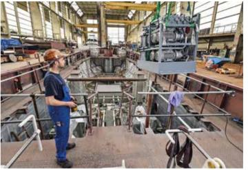
**KOMPAKTES KRAFTPAKET:** Der Block mit der Ruderhydraulik für das Planierschiff wird mit dem Hallenkran in den Maschinenraum gehoben.
