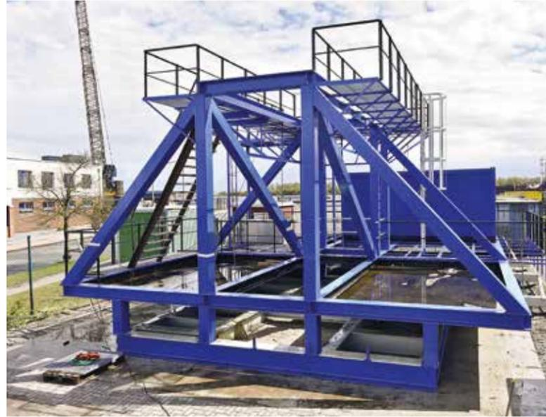
**TESTANLAGE:** Mit dieser Konstruktion können später Rettungsanlagen für Schiffe überprüft werden.
