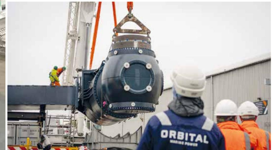
**HERZSTÜCK DER ANLAGE:** Die Turbine wird später mit Rotoren bestückt, die sich um 360 Grad drehen lassen. Das sorgt für einen maximalen Wirkungsgrad.
