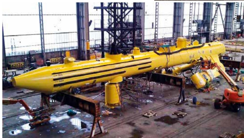
**RIESEN-ZIGARRE:** Der Schwimmkörper der ungewöhnlichen Konstruktion, hier noch ohne Rotoren, ist 72 Meter lang.
