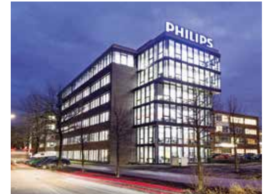
SPÄTSCHICHT: Einige Bereiche der Fertigung arbeiten auch nachts und am Wochenende.
