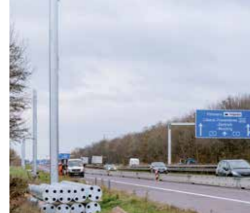
Baustelle an der A1 bei Lübeck: Die Masten stehen bereits, bald folgt die Oberleitung.
