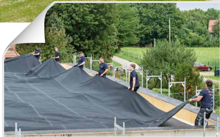
LEICHT ZU VERLEGEN: Die Planen von Carlisle wiegen deutlich weniger als die oft noch verwendeten Bitumenabdichtungen, die mit einem Brenner verschweißt werden müssen.
