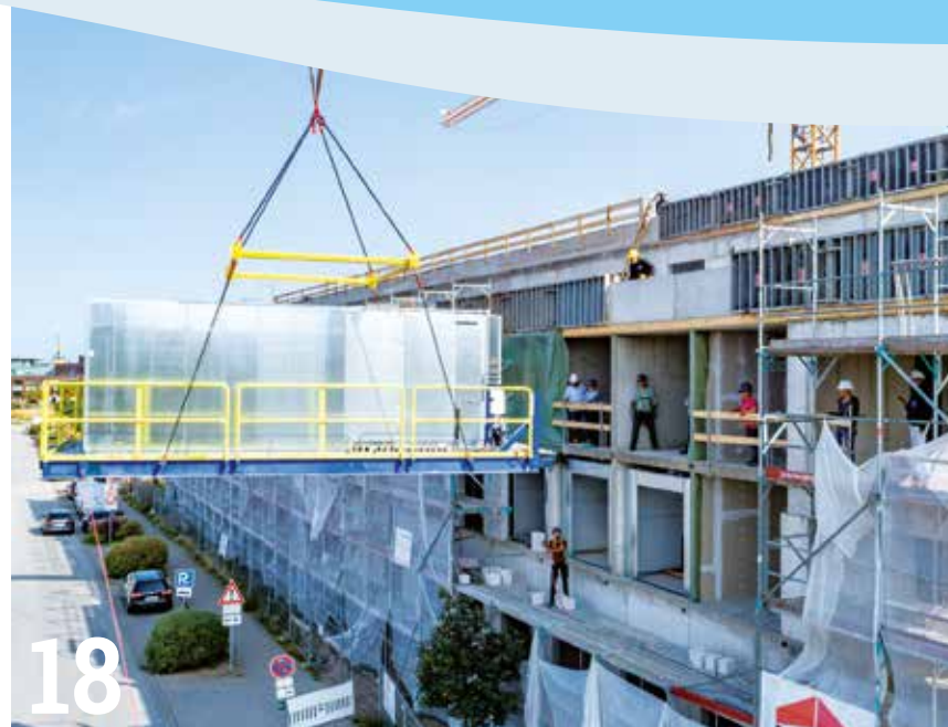
18 REIN DAMIT! In den Rohbau des neuen Werfthotels am Hafen von Wismar wurden originale Kreuzfahrt-Schiffskabinen wie Schubladen eingeschoben.
