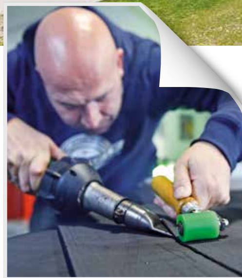
EINFACHES HANDLING: Schulungsleiter Marko Grimm zeigt, wie die Bahnen verbunden werden.
